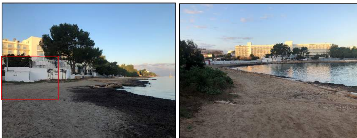
Ilustración 18. . Estado actual EBAR des Serra
