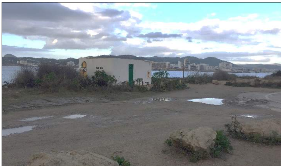
Ilustración 19. Estado actual EBAR des Pinet
