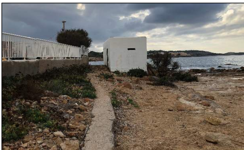
Ilustración 21. Estado actual EBAR des Fontanelles
